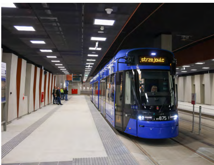
W ramach inwestycji powstał tunel o długości ponad 1200 m / fot. Jan Graczyński
