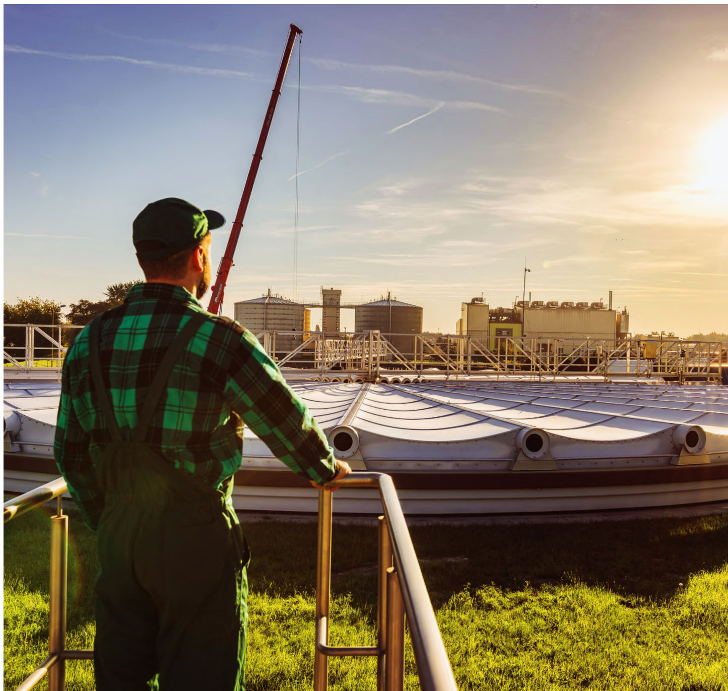
Inwestujemy w odzysk wody, nowoczesną gospodarkę energetyczną i własne źródła zasilania / fot. Wodociągi Miasta Krakowa
