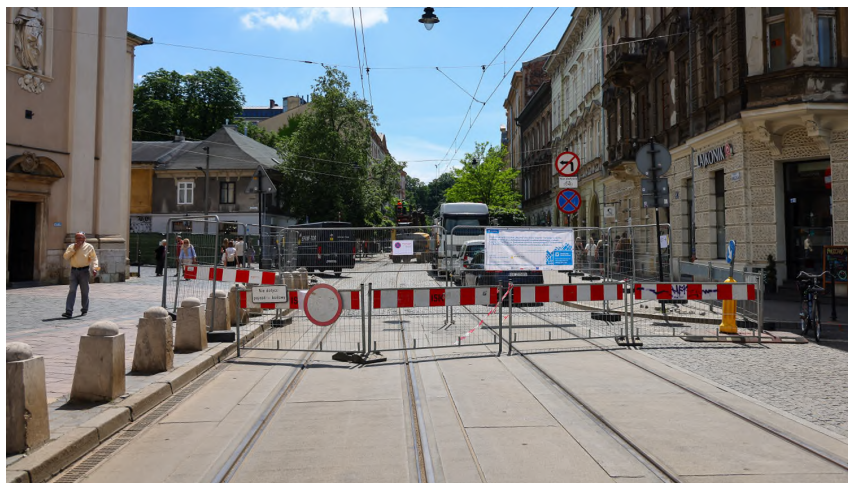
Prace przy węźle Bagatela / fot. Jan Graczyński
