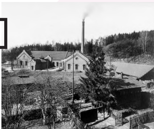
Zakład Pomp w Bielanych
