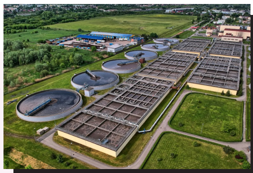
Oczyszczalnia Ścieków Płaszów
