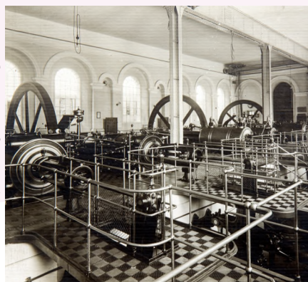
Wnętrze dawnego Zakładu Pomp w Bielanych
