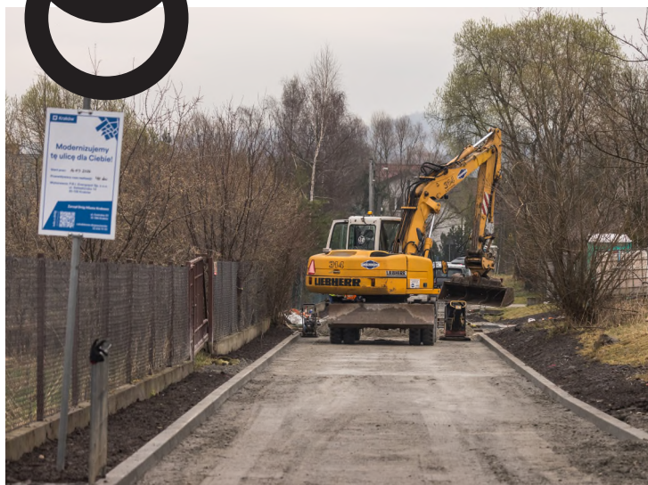
Ulica Zakarczmie (Dzielnica X Swoszowice) zyska wyremontowaną nawierzchnię jezdni z hydrofugu / fot. Bogusław Świerżowski
