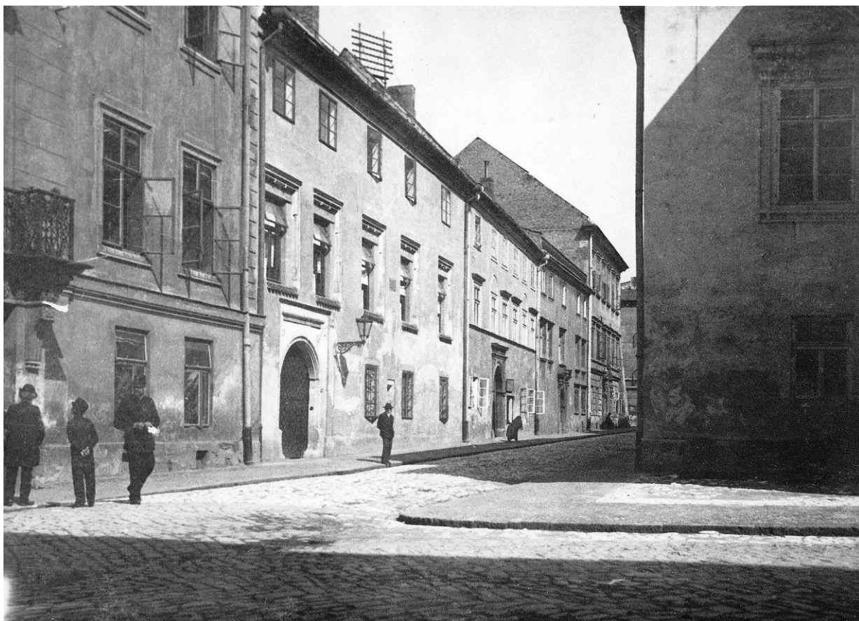
24. Zachodnia część placu Św. Marii Magdaleny, widok spod domu Zerwikaptur. Fotografia Franciszka Kleina wykonana po roku 1907, Archiwum Narodowe w Krakowie, sygn. Zbiór Fotograficzny A IV/606. Widoczna nawierzchnia placu, na którą składa się jezdnia z kostek brukowych oraz chodnik, zapewne z płyt porfirowych oraz otoczków wapiennych (w głębi).
