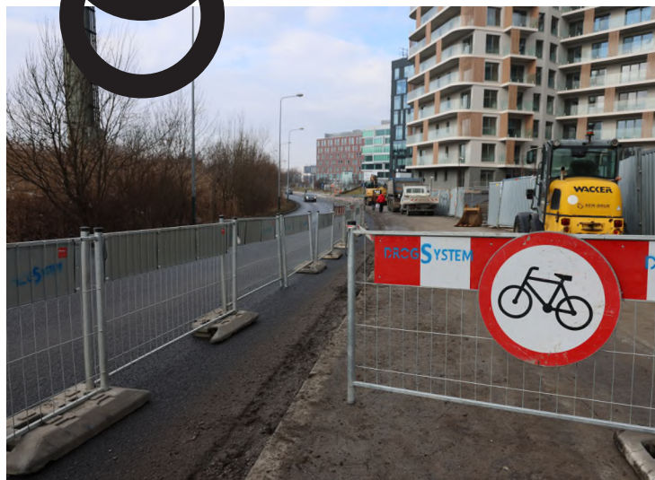
Do 30 kwietnia na ul. Puskarskiej prowadzone będą prace związane z wymianą nawierzchni ciągu pieszo-rowerowego. Zadanie to jest realizowane w ramach „Paktu dla krakowskich osiedli” / fot. Jan Graczyński
