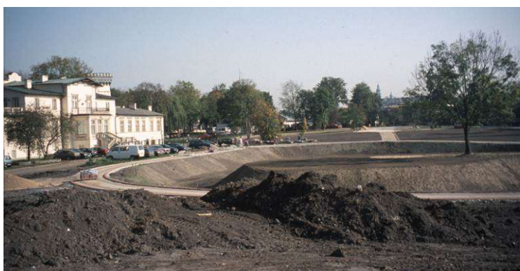
Fot. 105. Budowa parku Dębnickiego, ziemia z węgelnika pod staw posłużyła do usypania nasypu, z którego w oknie widokowym pokazała się sylweta Wawelu, fot. A. Zachariasz
