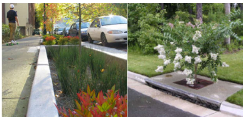
Fot. 181 i 182. Kieszonkowe niecki chłonne ( pocket wetlands ) i donice przyuliczne, źródła fot. : UACDC, Low Impact Development: a design manual for urban areas . Fay Jones School of Architecture, University Of Arkansas Press, Fayetteville, 2010.
