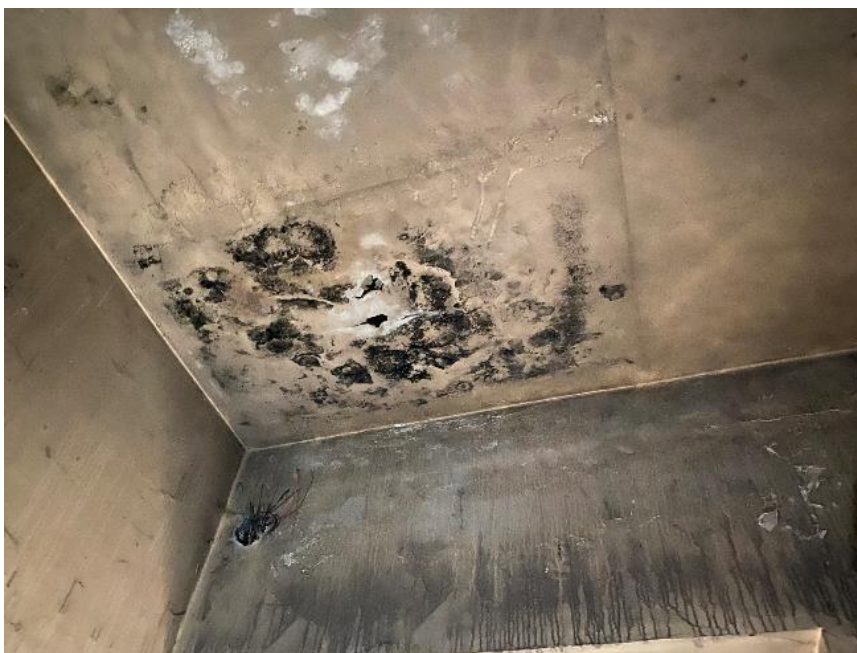
Fot. 10. Kolonie grzybni na zalewanym stropie części mieszkalnej.
