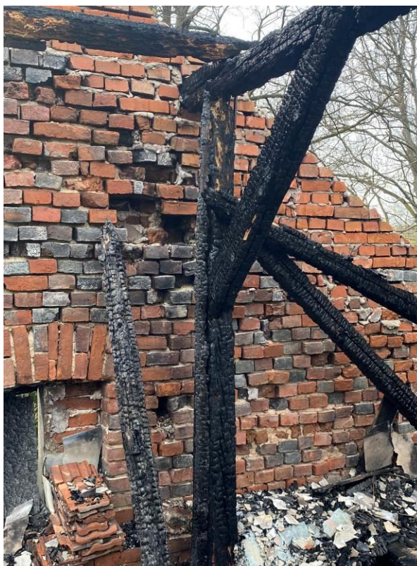
Fot. 17. Wzajemne stężenie ścian szczytowych i więźby drewnianej
