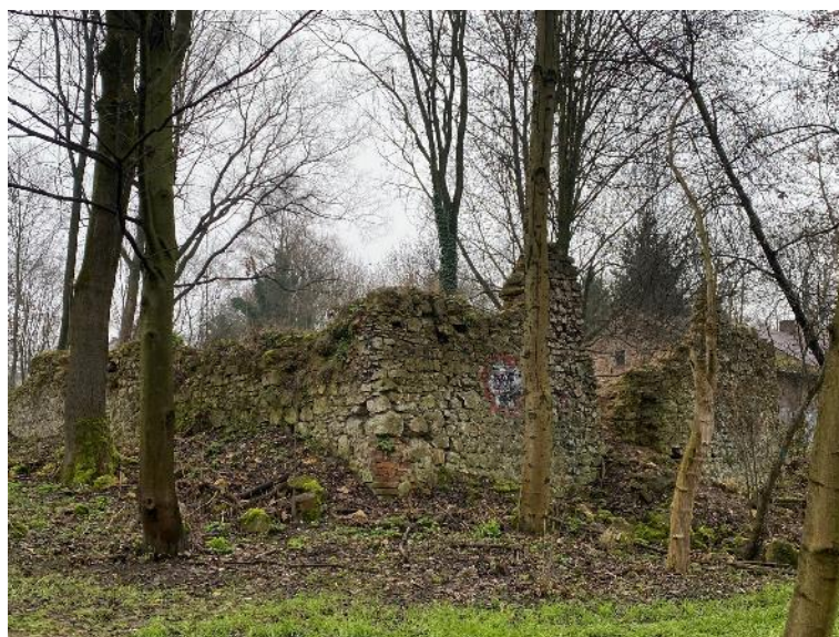
Fot. 3. Widok ruin po budynku gospodarczym – stajni.
