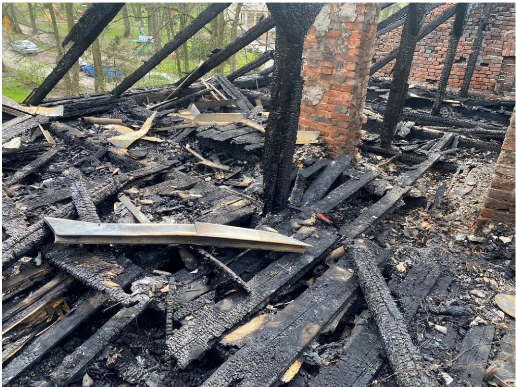
Fot. 14. Spalone deskowanie górne stropu nad I piętrem.
