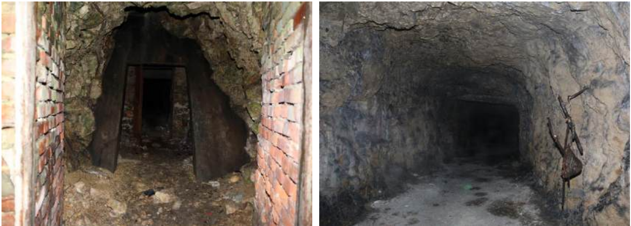
Kawerna „Bielany I”. Już w „przedsionku” widoczne są ślady penetracji obiektu przez ludzi. (Fot. M. Mydłowski)
