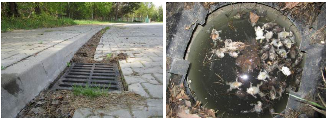
Przykład złej konstrukcji drogi osiedlowej (Radom, okolice użytku ekologicznego „Bagno”, stanowiącego miejsce rozrodu płazów). Wysoki krawężnik naprowadza wędrujące do miejsca rozrodu płazy wprost do studzienki odwodnieniowej. Tylko w jednym sezonie (IV-V 2013 r.) w tej studzienke zginęło kilkaset osobników grzebiuszki ziemnej. (Fot. M. Mydłowski)
