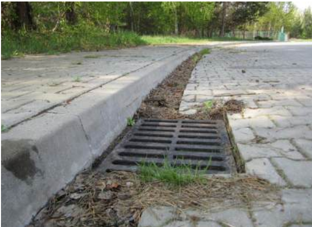
Przykład źle zaplanowanego (i wykonanego) systemu odwodnienia drogi osiedlowej (Radom, okolice użytku ekologicznego „Bagno”). Wysoki krawężnik naprowadza wędrujące do miejsca rozrodu płazy wprost do studzienki odwodnieniowej. Tylko w jednym sezonie (IV-V 2013 r.) w tej studzience zginęło kilkaset osobników grzebiuszki ziemnej. (Fot. M. Mydłowski)
