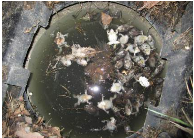
Przykład źle zaplanowanego (i wykonanego) systemu odwodnienia drogi osiedlowej (Radom, okolice użytku ekologicznego „Bagno”). Wysoki krawężnik naprowadza wędrujące do miejsca rozrodu płazy wprost do studzienki odwodnieniowej. Tylko w jednym sezonie (IV-V 2013 r.) w tej studzience zginęło kilkaset osobników grzebiuszki ziemnej. (Fot. M. Mydłowski)
