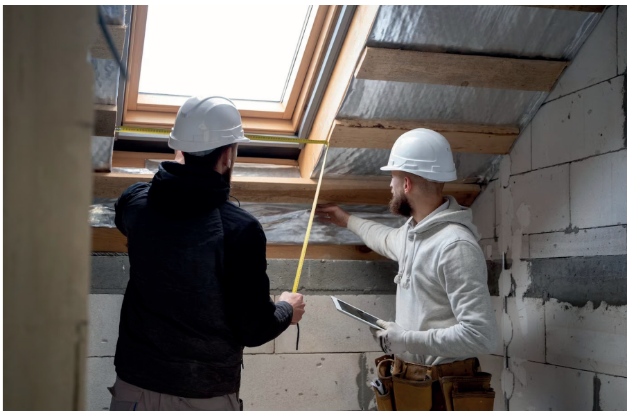
Zdjęcie 3: Ocieplenie dachu budynku
