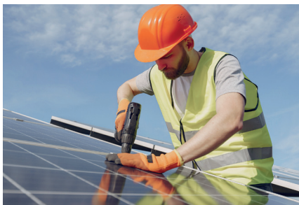
Zdjęcie 4: Montaż instalacji fotowoltaicznej
