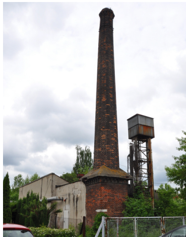
Kotłownia z kominem
