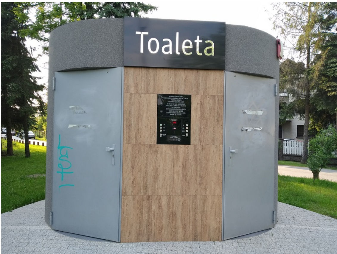
Przykładowy budynek toalety w innej lokalizacji w Krakowie.
